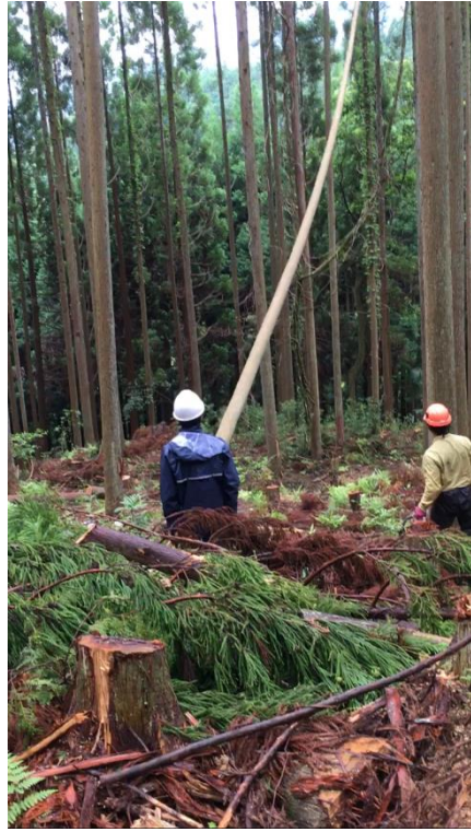
かかり木が倒れる途中の様子
